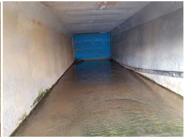
BOX내부 2런 보수현황
